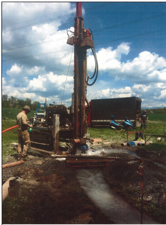
Obr.č. 1: Přetok na vrtu RK-4P ve výši 30 l/s
